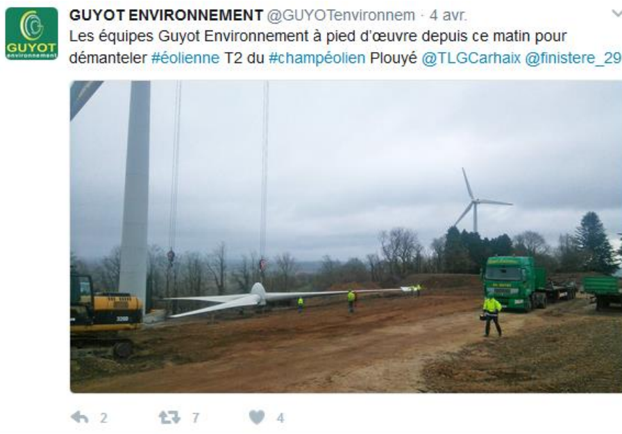
Figure 12 : Démantèlement d'un parc éolien à Plouyé
