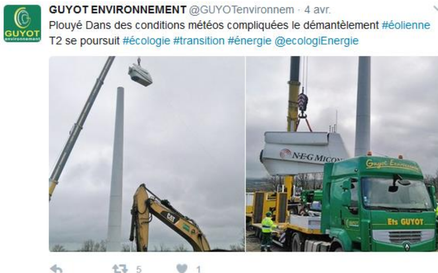
Figure 13 : Démantèlement d'un parc éolien à Plouyé (2)
